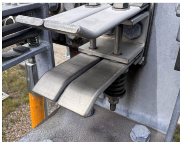
断路器 (LS) 接点の手入れと 確実なメンテナンス
