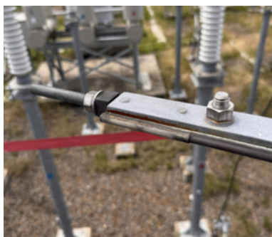
手動LSのロッドの張り・断路 部の入り具合をシビアに調整
