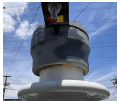
SP碍子の清掃および頂部 の塗装施工
