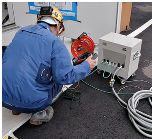
各測定線を接続し、測定条件を確認
