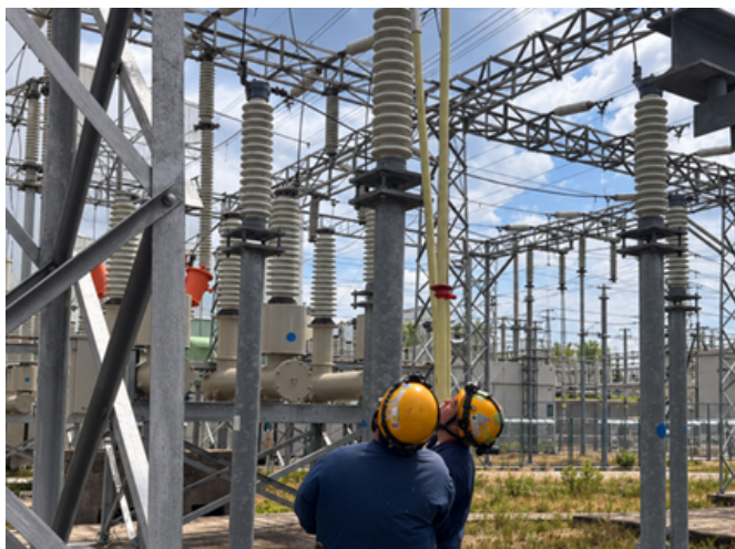
構内活線状態での対象機器 (LS) 切り離し作業
