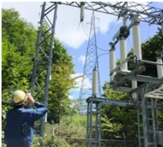
双眼鏡で77kV架線を確認
