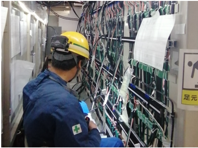
盤内配線・切替 一本のミスも許されない配線作業
