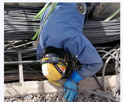
複雑なケーブルを確認しながら撤去
