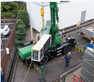
制御盤をクレーンで搬入
