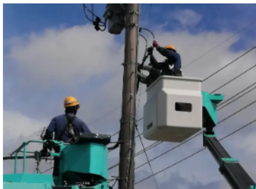
既設ケーブル撤去
