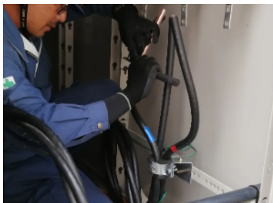
電柱側・キュービクル側で端末処理
