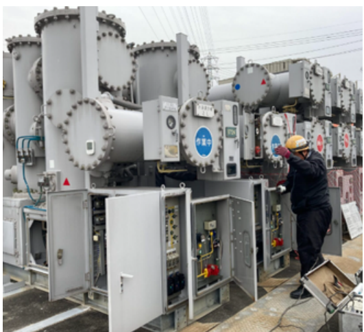
GIS機器の操作機構を点検
