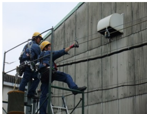
約70mの新設ケーブルを布設
