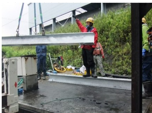
新基礎とH鋼ベースを設置
