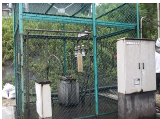
耐荷重に懸念があった既設基礎
