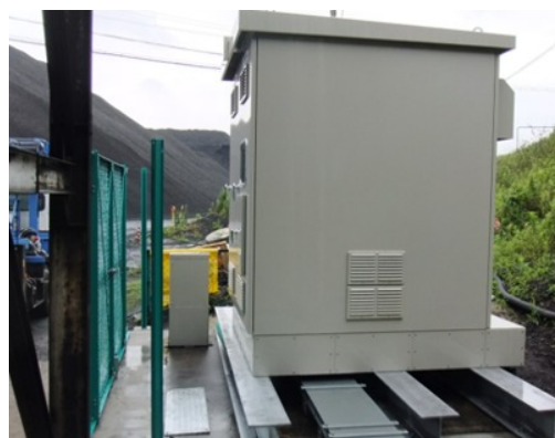
キュービクル据付完了
