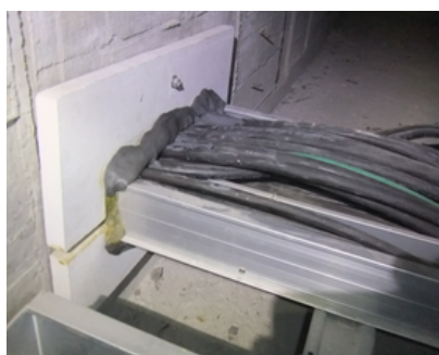
貫通部処理（パテ埋め）
