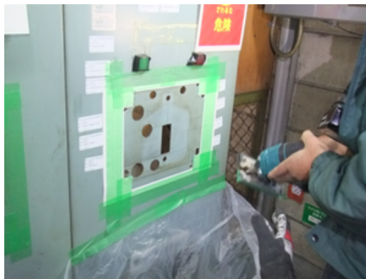
旧VCB撤去後盤加工 (切粉飛散防止の養生実施)
