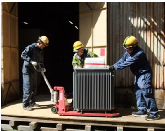
仮設ステージを敷設し慎重に搬入路を通過
